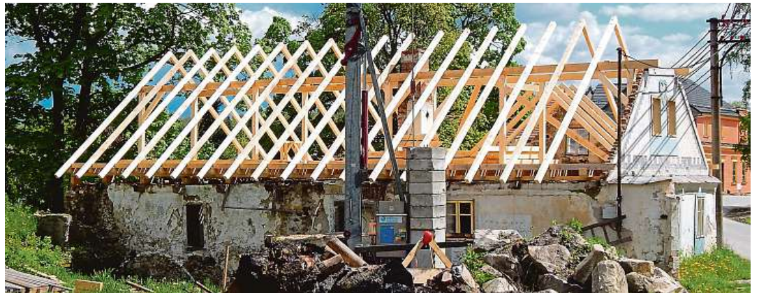
Nový krov V loňském roce spolek Sedlečká opravil za pomoci dobrovolníků střechu. 3x foto: archiv spolku
