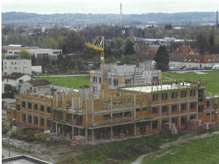
Podoba stavby II. etapy Jihočeského vědeckotechnického parku na začátku listopadu.
